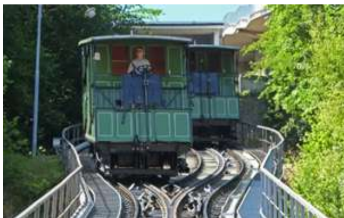
中間地点でのすれ違い
